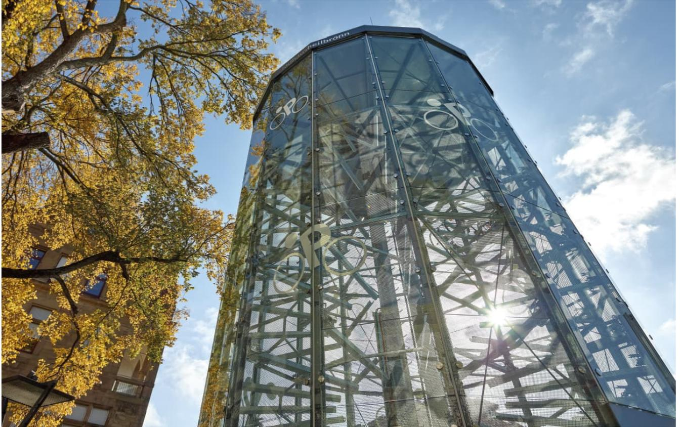
Der WÖHR Bikesafe ist ein sicheres und platzsparendes Parksystem für Fahrräder. Auf 4 bis 8 Parkebenen können überirdisch in einem Turm und / oder unterirdisch in einem Schacht bis zu 192 Fahrräder geparkt werden.
